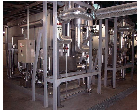
図5-1 吸収冷凍機
