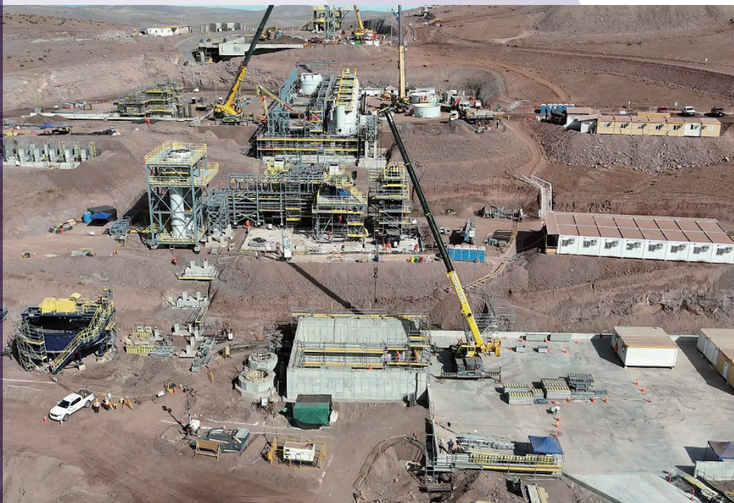
建設中のアルケロス銅鉱山のプラント
