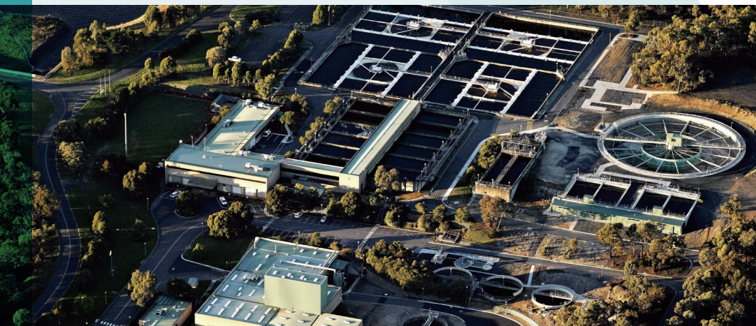
Winke Water Treatment Plant at Sugarloaf Reservoir (写真提供:メルボルンウォーター)
