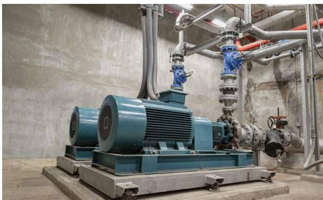
▶ 場内各所で冷却水ポンプを使っている。冷却水ポンプを構成する回転機器などの部品が劣化すると、冷却水ポンプの故障につながる。さらに、冷却水ポンプが故障し、冷却水の温度を保てなくなると、冷却したい設備にも損害が出かねない。
