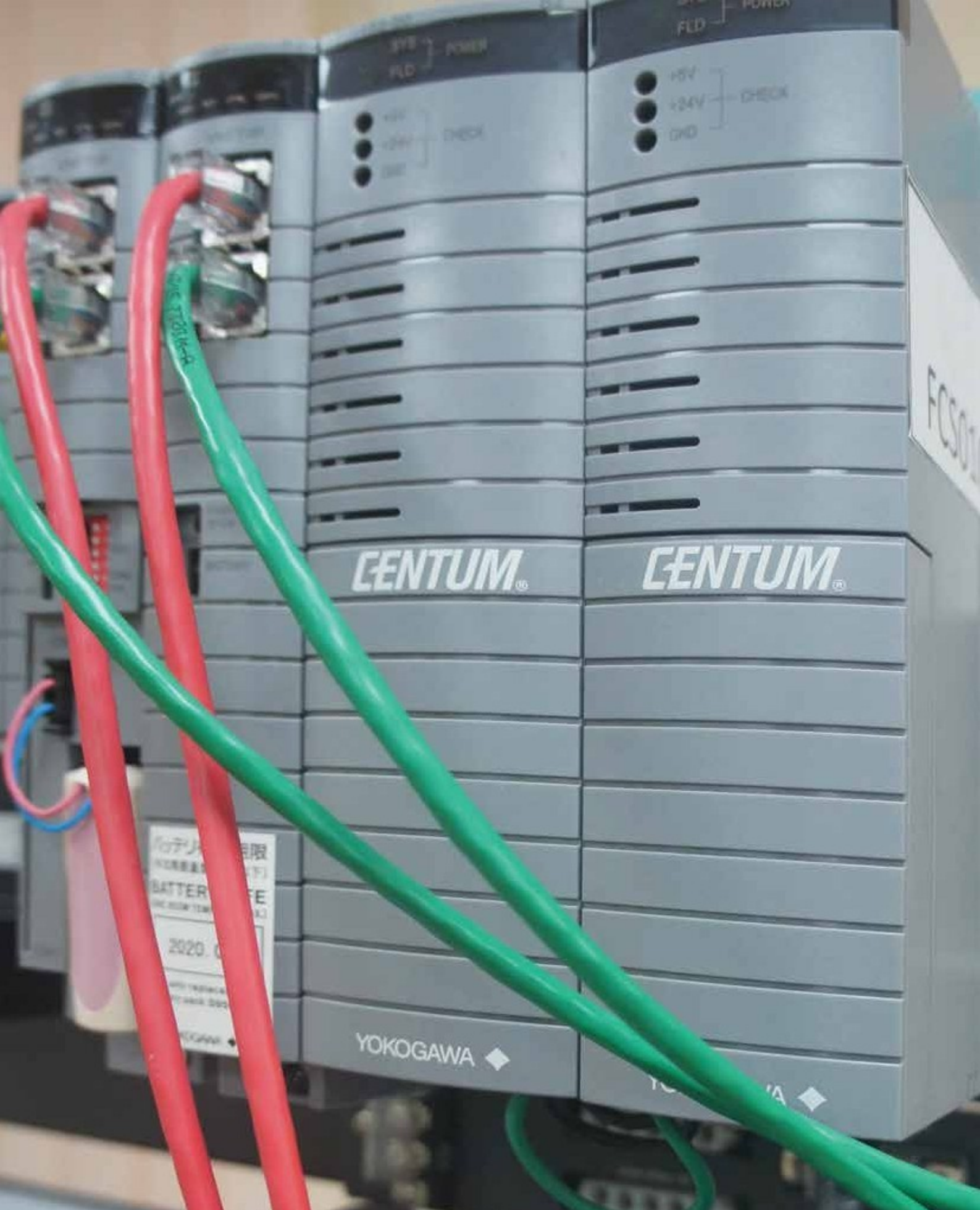
Блок 1: АСУ ТП (Распределённая система управления CENTUM VP)
