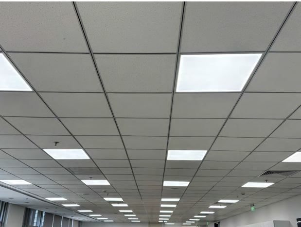
公司替换节能照明
