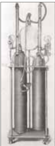
Eine der ersten Anwendungen von Rotametern war im Narkose-Apparat von Maximilian Neu.
